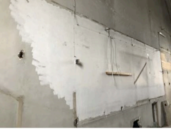
Rückwand nach Abbau der Orgel
